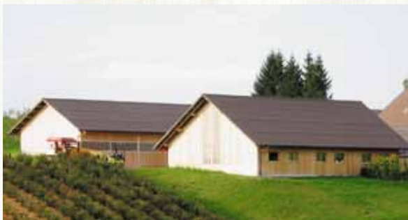
Lager- und Einstellraum
