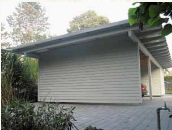
Autounterstand passend zu Wohnhaus
