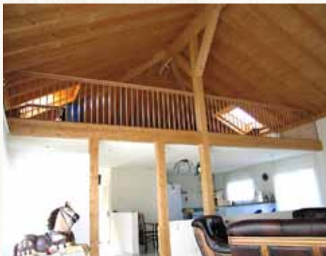
Sichtkonstruktion im Wohnbereich
