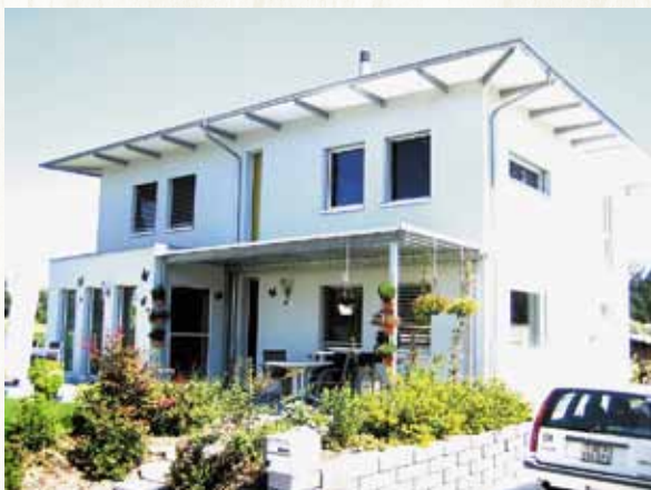
Fassade mit Abrieb auf Holzfaserplatte
