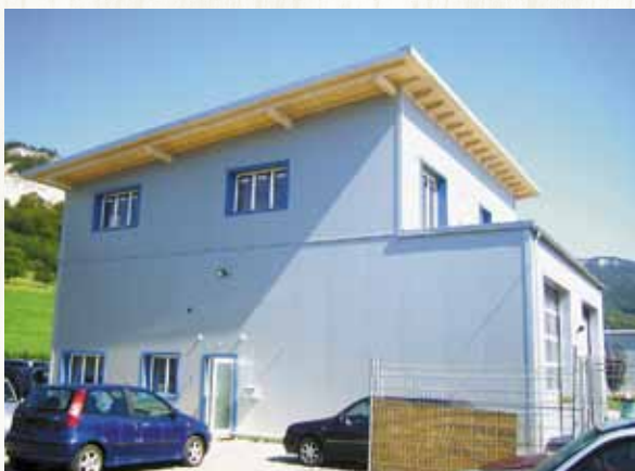
Autogarage mit Wohnhaus, alles in Holzelement, Verkleidung mit Blechpaneelen
