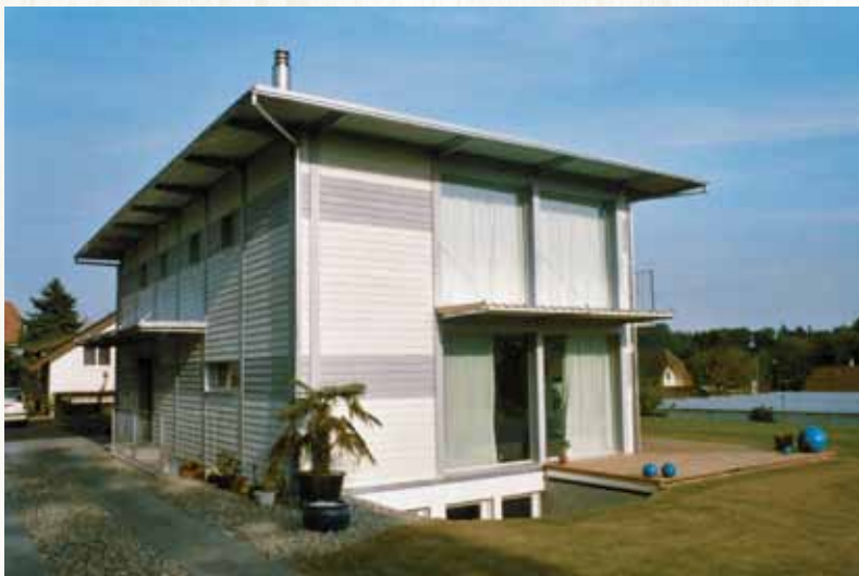
Holzelementbau ab Keller
