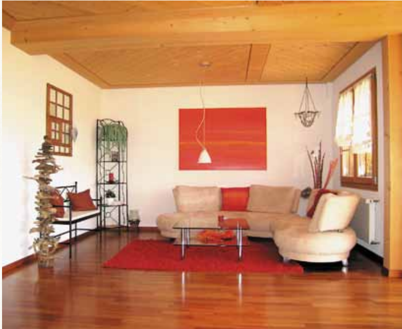
Parkettboden, Täferdecke und Leichtbauwände
