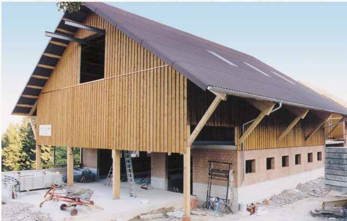
Kostengünstige Aussenschalung Scheunen-Neubau
