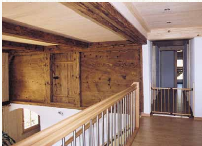
Ausbau von Wohnzimmer / Galerie
