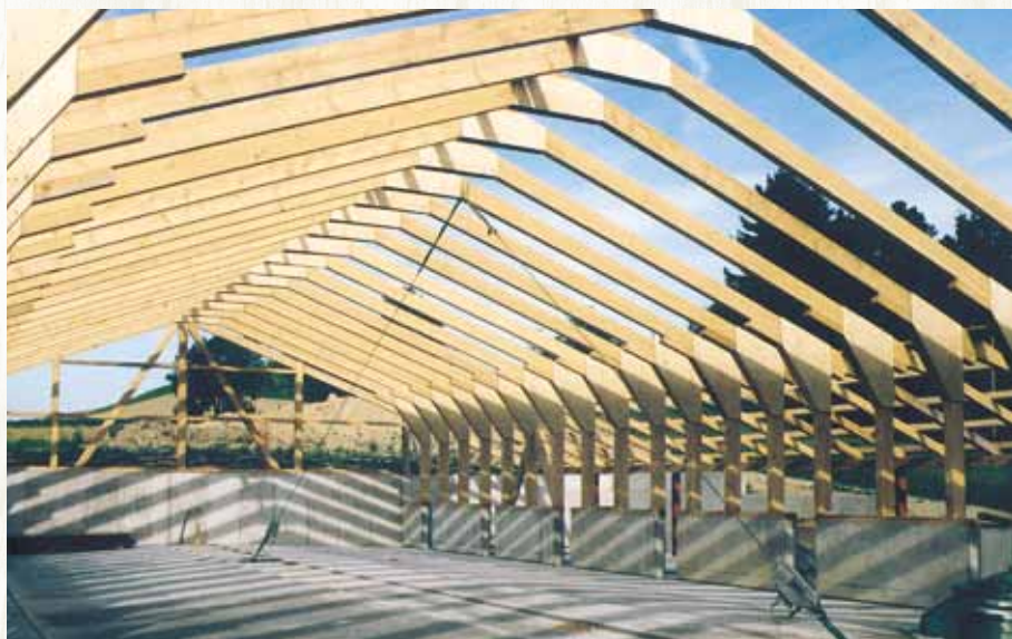
Stützenfreie Massivholz-Binderkonstruktion
