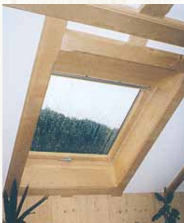
Dachfenster-Einbau / -Verkleidung
