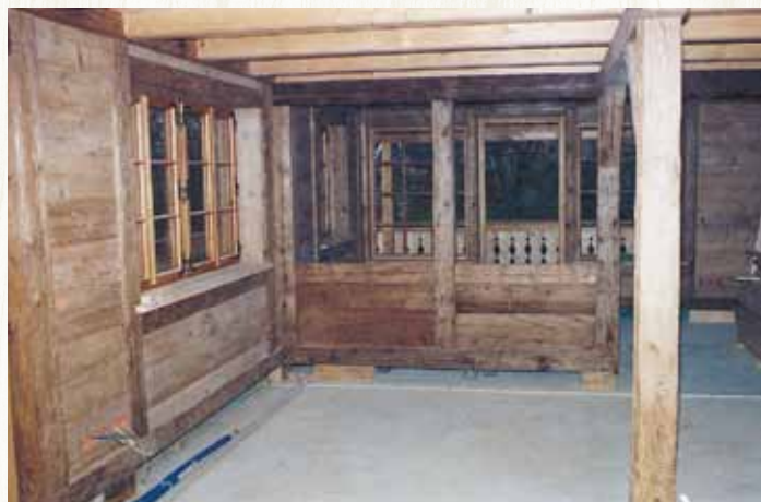
Verbauen von rustikalem Holz in Neubau
