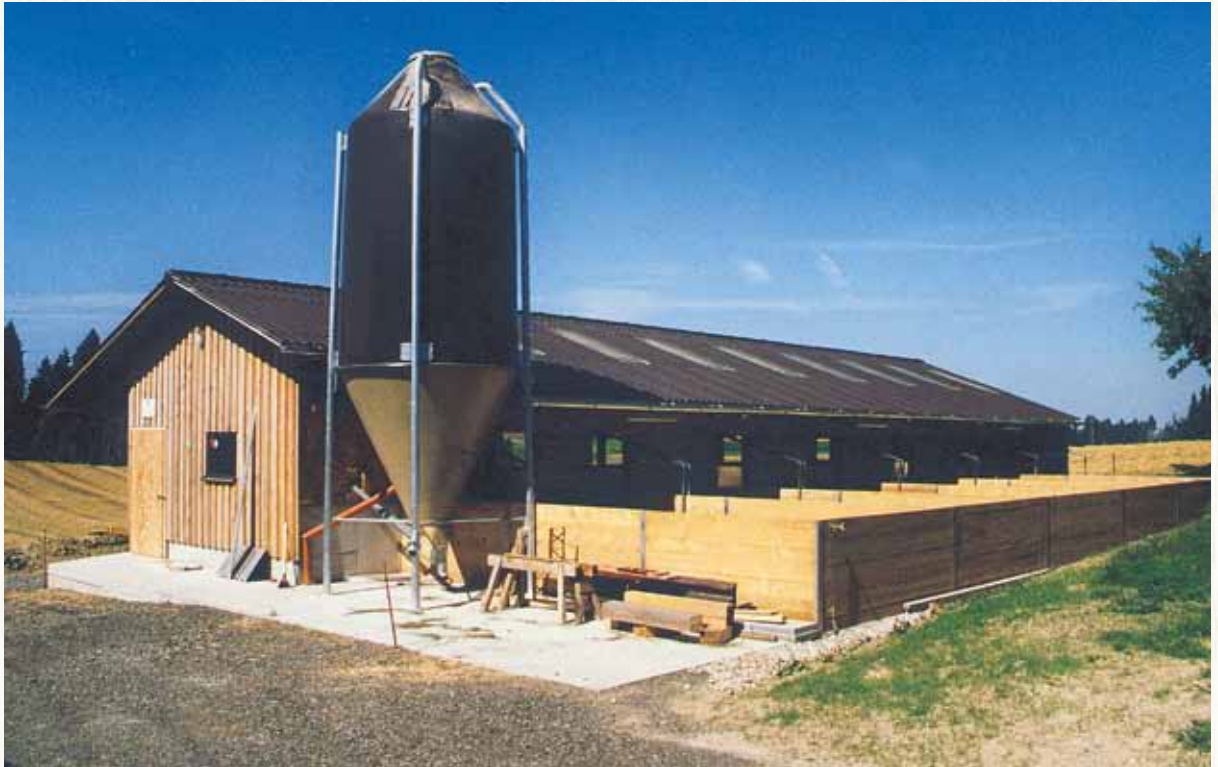
Schweinestall-Holzkonstruktion (ab Betonboden)
